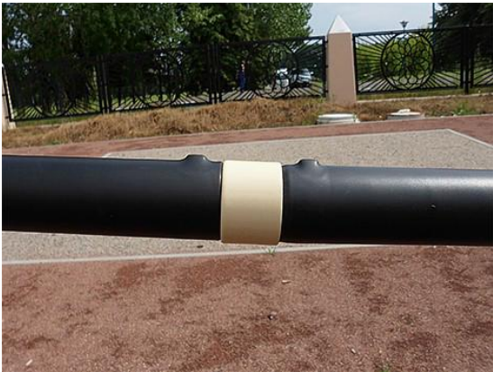
رسم توضيحي 4-16: تركيب قطع المجس المستقيمة
